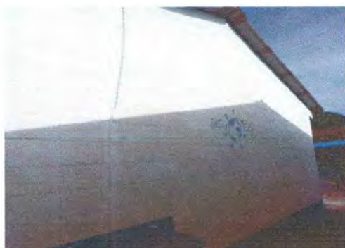
Foto 3: Pintura de interiores y exteriores
