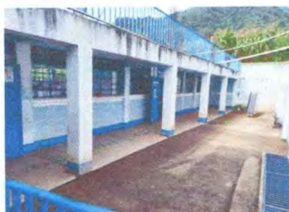
Foto 8: Pintura de exteriores
