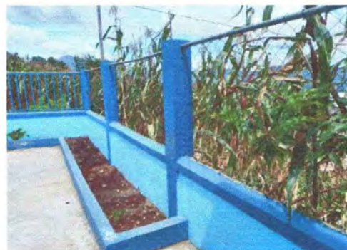
Foto 4: Sustitución de baranda de metal
