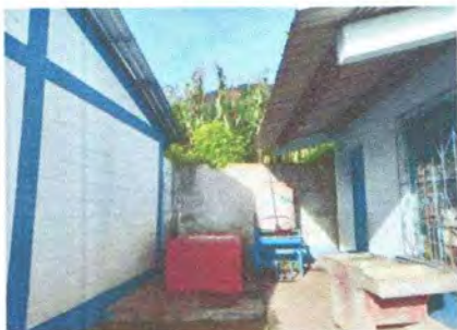
Foto 9: Instalación de estructura portante de metal en la pila.
