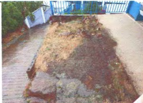
Foto 2: sustitución de torta de concreto
